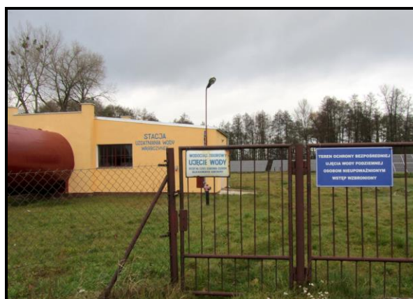
Stacja Uzdatniania Wody
