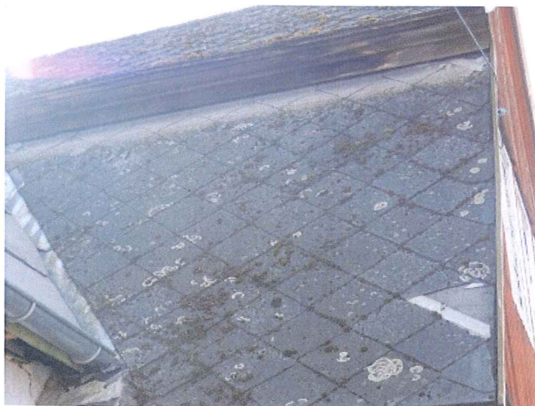
Zdjęcie nr 4- Stan poszycia dachowego
