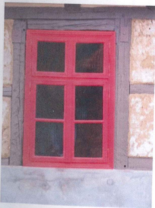
Okno dawnej piekarni po pracach konserwatorskich
