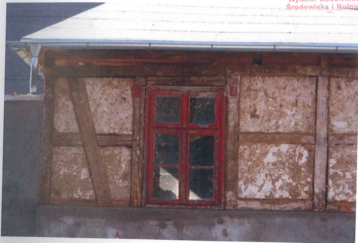
Elewacja północna dawnej piekarni z zachowanym oknem przed pracami konserwatorskimi.
